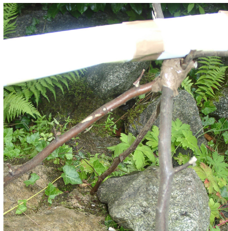
Abb.: Pipeline-Konstruktionen, Unterbauten und eine Alternative aus Plastikrohr.
